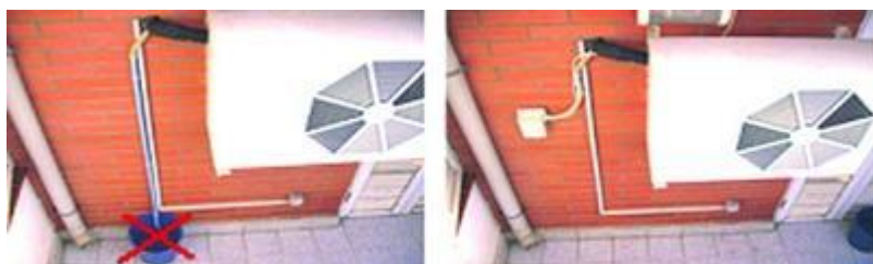
HYPPO: Kondenzvíz párologtató 1,5 l/óra, 25 ml/perc
